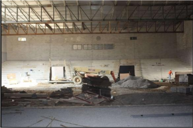
Fig. 5 Precast Auditorium risers
